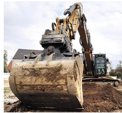
Der Bagger begann – corona-bedingt – ohne Korkenknallen zum Spatenstich Ende April seine Arbeit.
