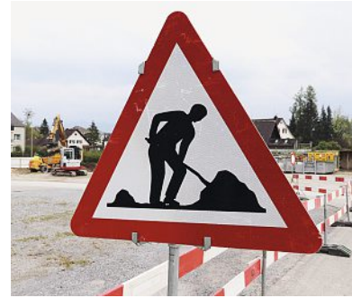
Die Baustelle an der Esslingerstrasse.
